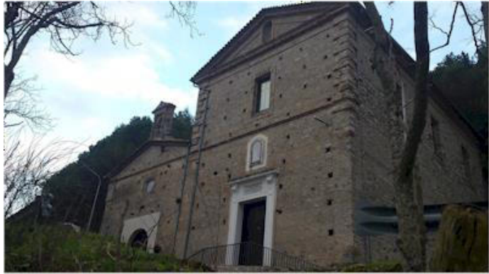
Chiesa Santa Maria della Sanità
