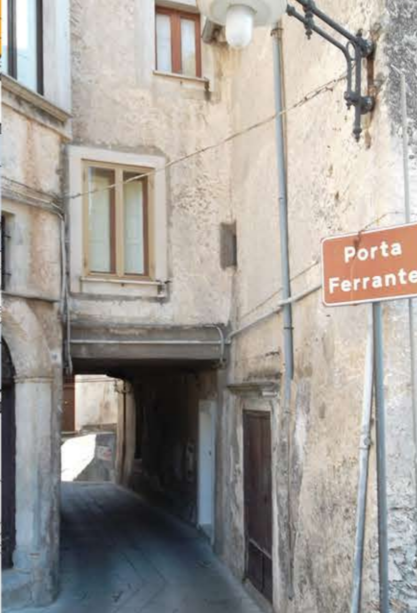
FOTO N. 4 : Porta prima cinta muraria
